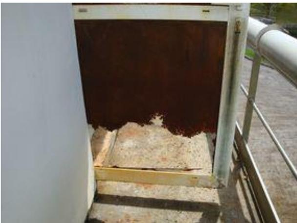
Figure 2.1 - Porte du local : corrosion H<sub>2</sub>S
